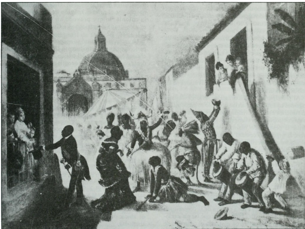
El asentamiento de la población africana y sus descendientes en las áreas urbanas, propició el desarrollo de los cabildos (obra de V. P. Landaluze).
